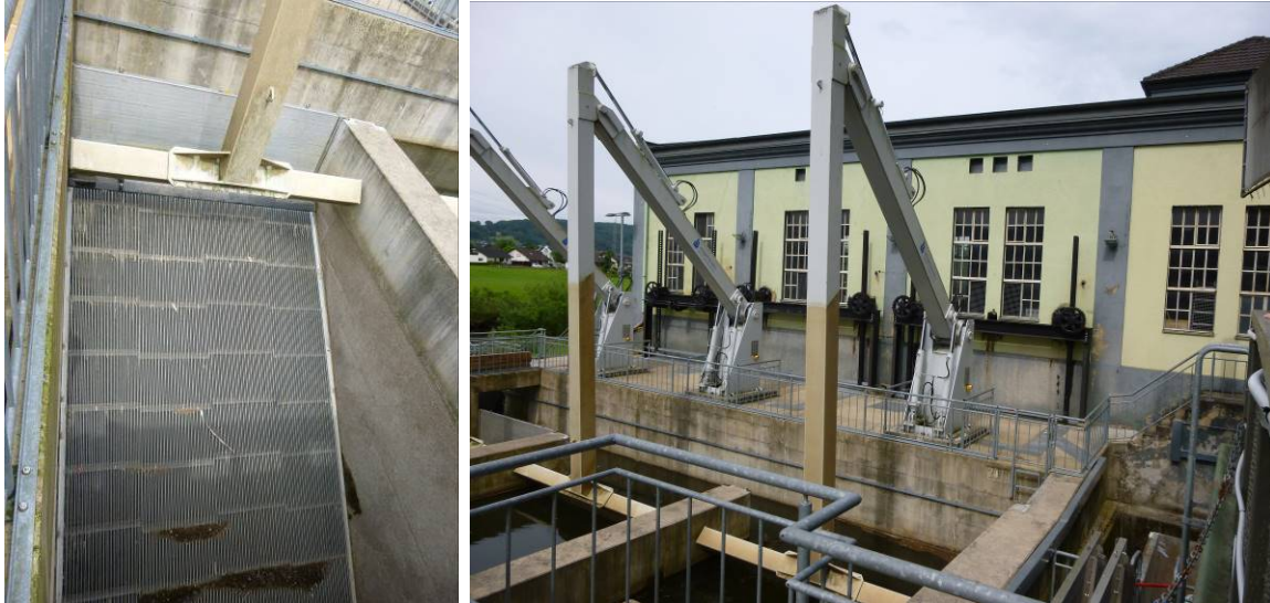
Figuur 9: Verticaal rooster (10 mm) van de voorziening voor stroomafwaartse vismigratie aan de waterkrachtcentrale Unkelmühle
