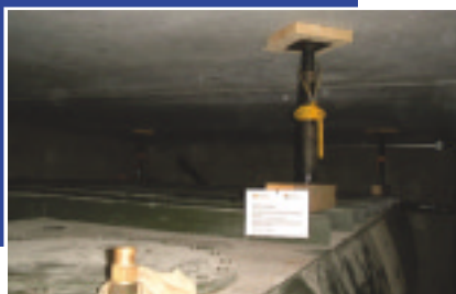
Bescherming van een olietank tegen de opwaartse druk (Basel)
