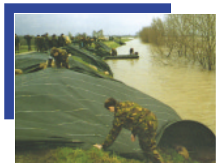
Rampenpreventie: afdichting van een dijk
