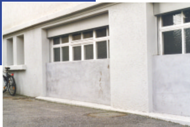
Afdichting van openingen (permanent) door middel van een gevelbekledingsplaat
