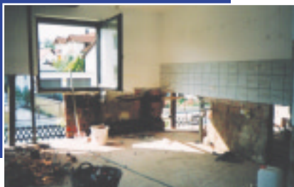
Vervanging van het metselwerk wegens olievervuiling in Neustadt aan de Donau (Landkreis Kelheim) in 1999
