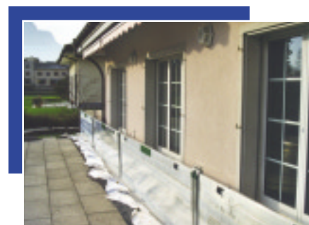
Afdichting van de gevel (mobiel)
