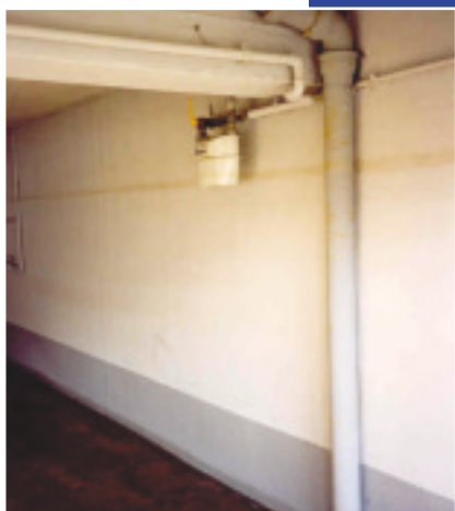
Verhoogde plaatsing van de gastoevoer
