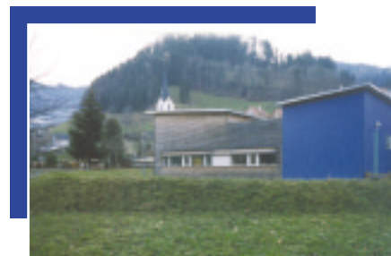
Aanleg van een beschermingswal
