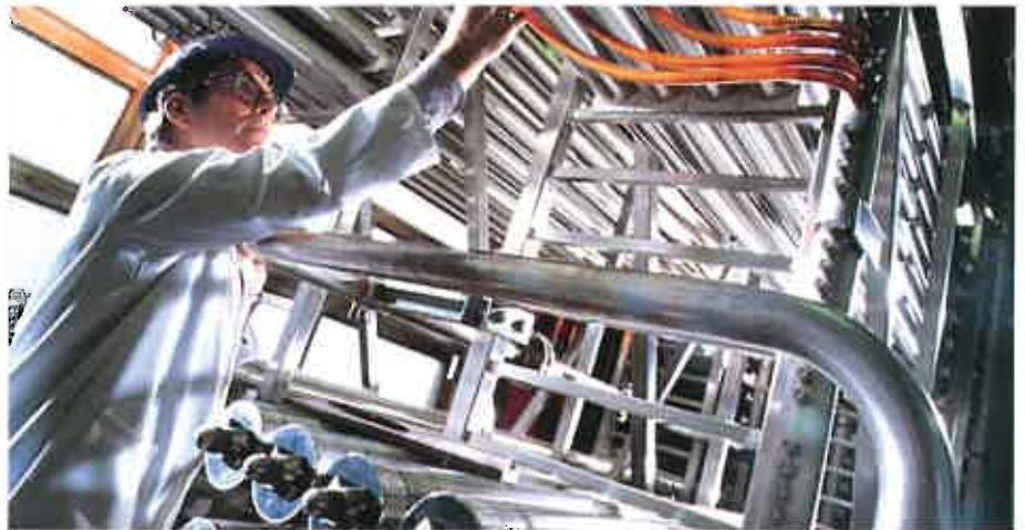
Moderne afvalwatertechniek zorgt ervoor dat geen schadelijke stoffen vrijkomen
