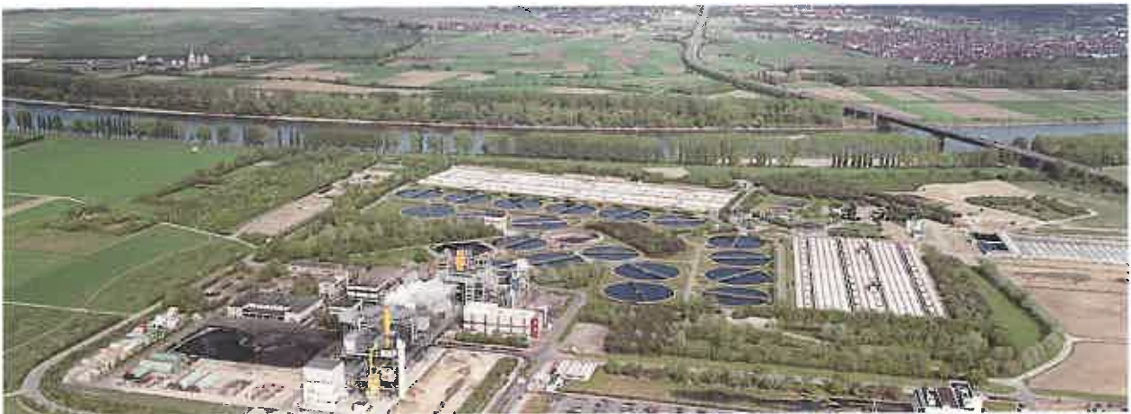
Rioolwaterzuiveringsinstallatie aan de Rijn bij Ludwigshafen
