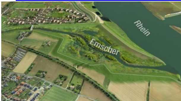
Figure 12 : débouché de l'Emscher (photo : Emschergenossenschaft)
