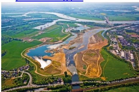
Figure 13 : nouveau débouché de la Lippe (photo : Lippeverband)
