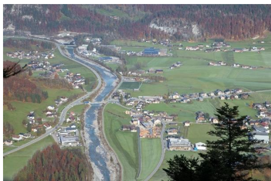
Figure 3 : protection contre les inondations sur la Bregenzach (photo : Land de Vorarlberg)
