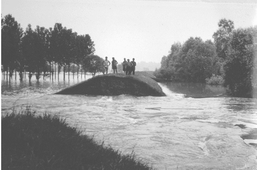
Deichbruch am Oberrhein in Flotzgrün (Hochwasser Juni 1953)
