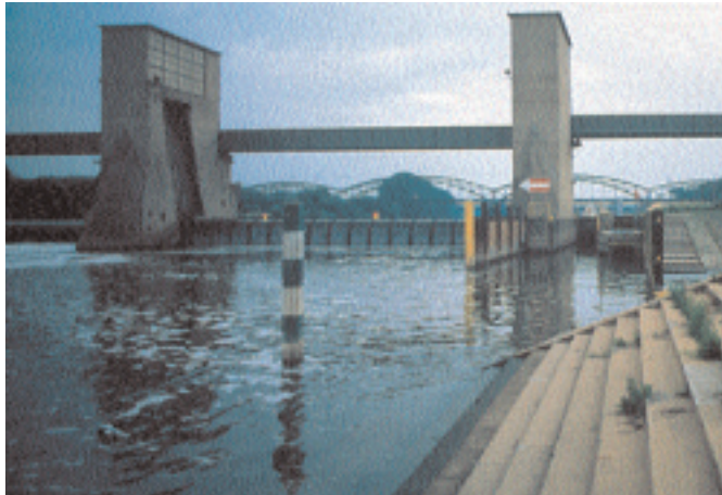
Die unterste Staustufe am Main bei Kostheim mit einem untauglichen Beckenpass verhindert den Fischaufstieg aus dem Rhein.
