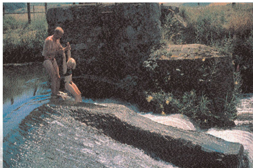
Die Hainmühle an der Ohm hat einen für Fische untauglichen Beckenpass.
