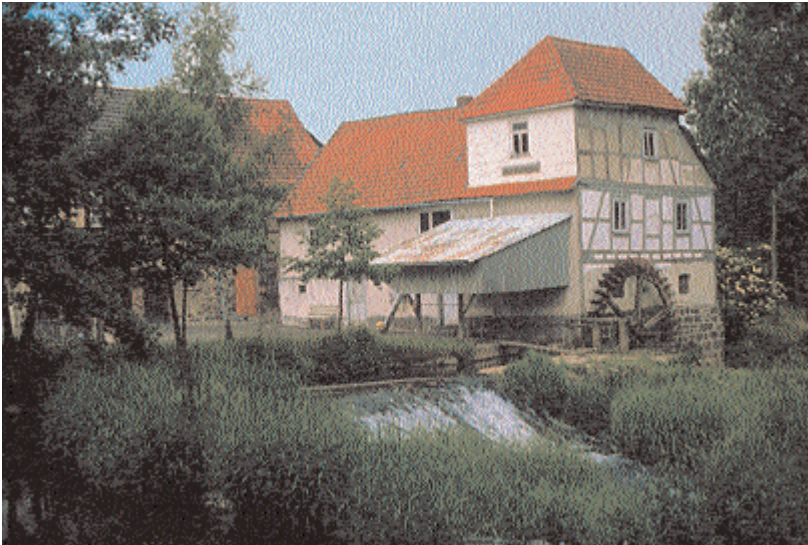
Das Wehr der Rosselmühle an der Felda im Lahn-Ohm-System hat keine Aufstiegshilfe.
