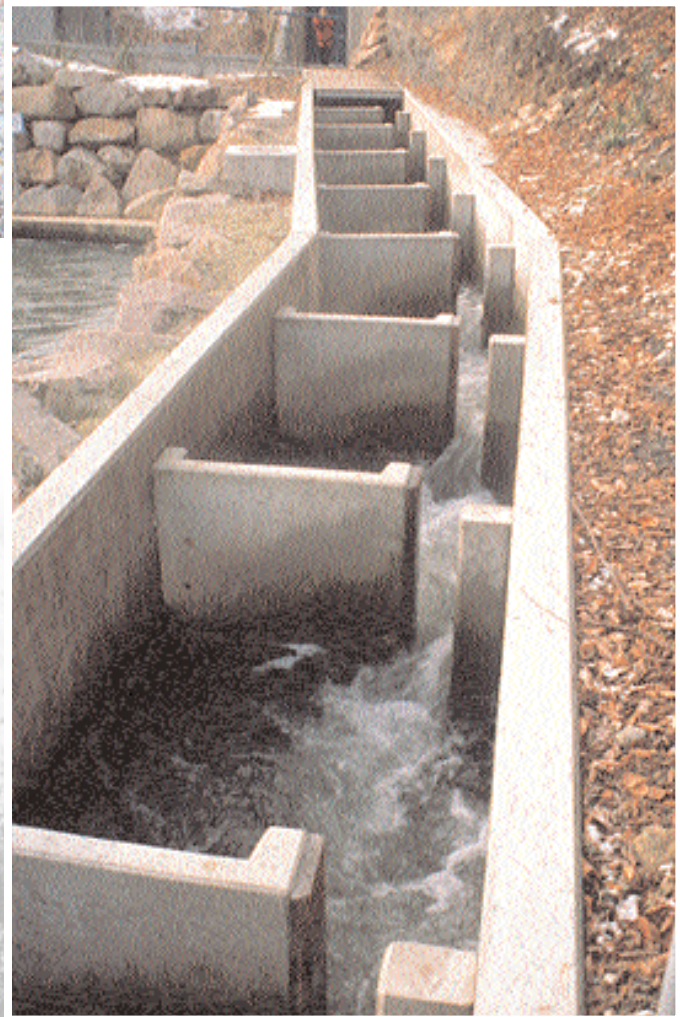
Schlitzpass für Lachse am Kraftwerk „Neue Welt“ in der Birs bei Münchenstein.
