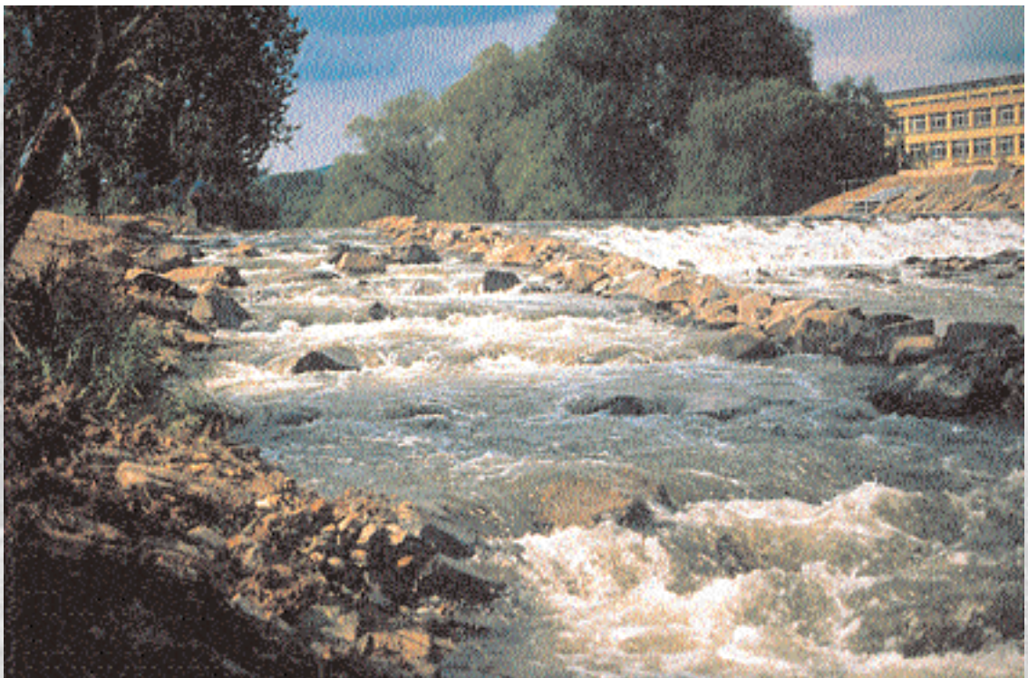
Neue Fischrampe am Buderuswehr in der Dill
